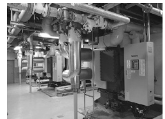
現在施工中の県営サンアリーナ空調熱源設備
